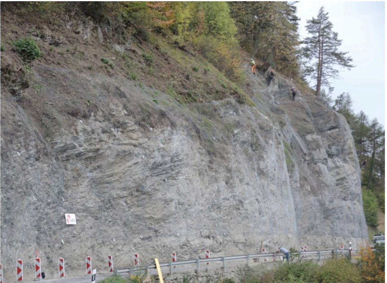
Die Netzverlege arbeiten neigen sich dem Ende zu
