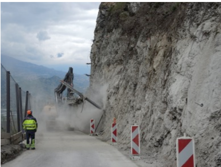
Die Bohrarbeiten für die Anker. Bohrdurchmesser 110mm Bohrtiefe bis 10m
