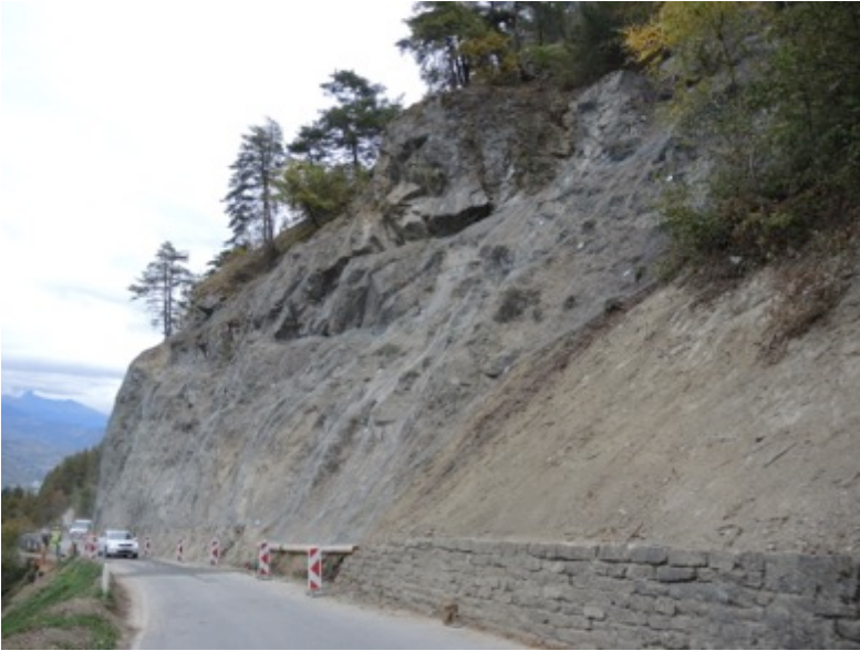
Die Arbeiten sind abgeschlossen und die Strasse wieder für den Verkehr offen
